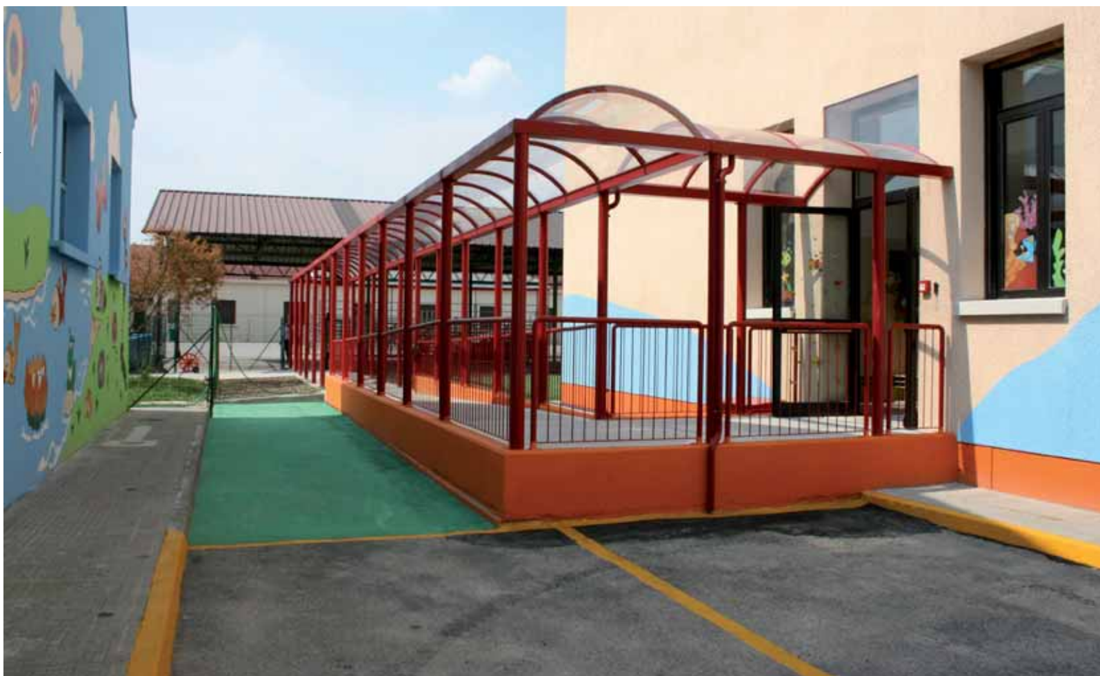
L'Asilo Nido "Domenico Agusta" presso l'aeroporto "Francesco Baracca" di Casarsa della Delizia (PN). Kindergarten named after 'Domenico Agusta' at the 'Francesco Baracca' airport in Casarsa della Delizia.
