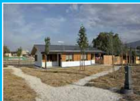
FIG. 5 - ESEMPIO DI MODULO ABITATIVO PREFABBRICATO A L'AQUILA TABLE 5 - AN EXAMPLE OF PRE-FABRICATED ACCOMMODATION MODULE IN L'AQUILA
