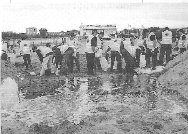
Esattamente un mese dopo gli stessi volontari sono stati impiegati nella realtà (come scritto più sotto) durante le piene del Po e dell'Adige, per il monitoraggio diurno e notturno degli argini e dell'onda di piena, oltre all'individuazione e contenimento di fontanazzi.
