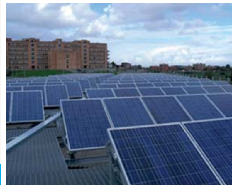
Impianti fotovoltaici, nuova fonte energetica ecologica ubicati presso una caserma Photovoltaic systems, new energy source label located at a barracks.
