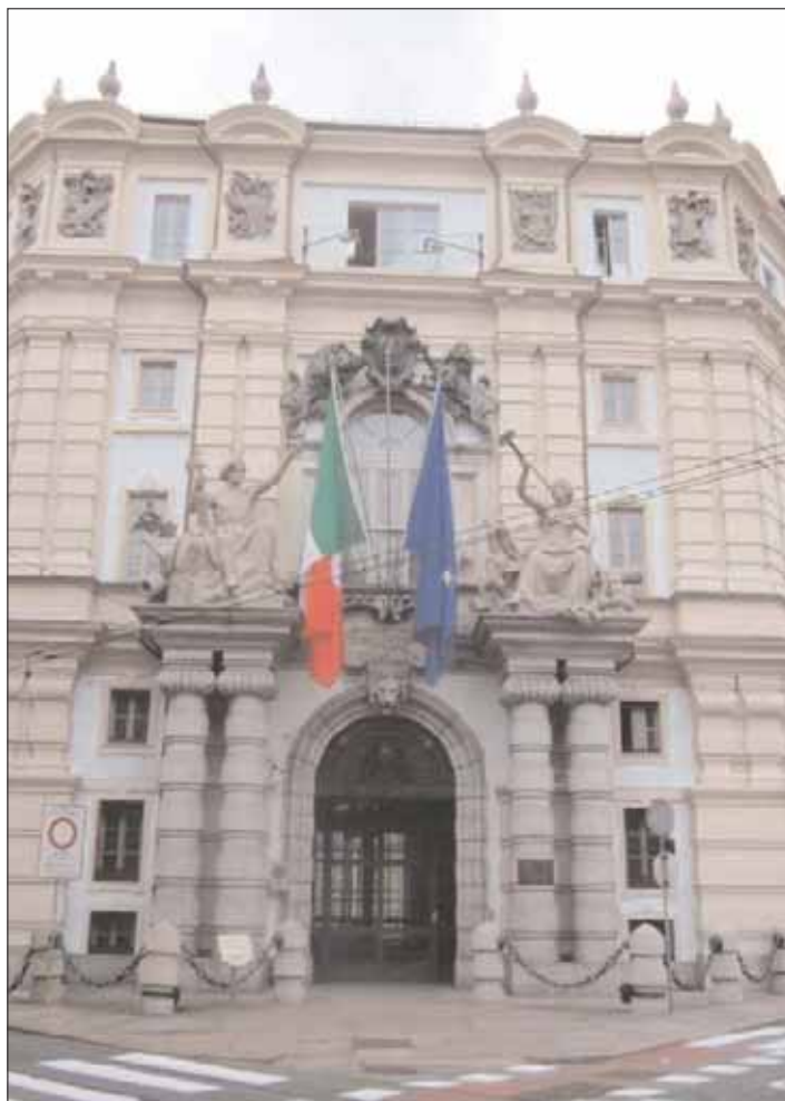
Torino - palazzo Ex Arsenale - Rifacimento facciate
