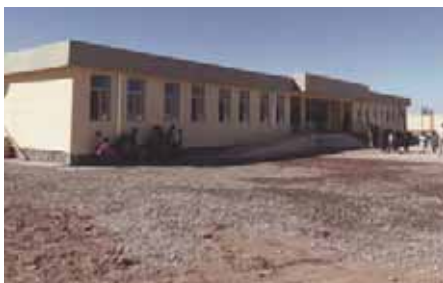
Una delle scuole realizzate dal PRT
