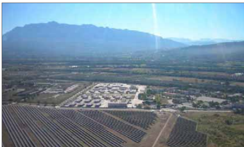
FIG. 45 - IMPIANTI FOTOVOLTAICI INSTALLATI «A TERRA» PRESSO IL COMPRESORIO DI PERSANO. TABLE 45 - PHOTOVOLTAIC SYSTEM (GROUND INSTALLATION), PERSANO MILITARY COMPOUND
